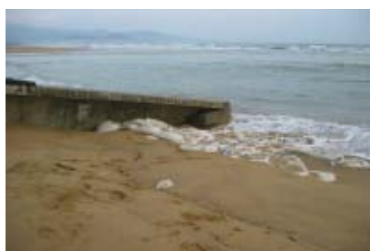
照片 3-15 跨河大橋橋墩裸露，堆置沙包
